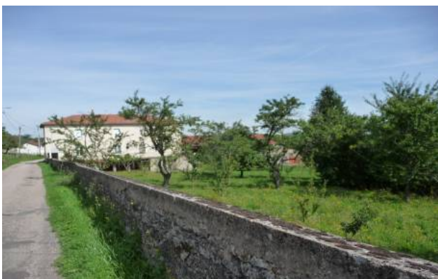
Chemin des Clos – Mur en limite de verger
