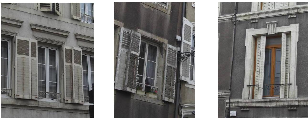
Baies d'étage courant à linteaux droits moulurés ou unis
