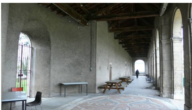
Galerie des Prémontrés montée sur l'ancienne courtine et la tour sur l'eau.
