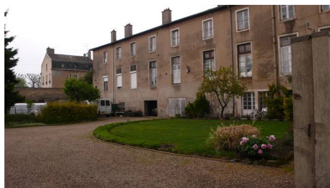
Vestiges du couvent de la Visitation reconverti en logements
