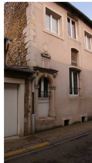
Autres vestiges au 25 bis rue étroite
