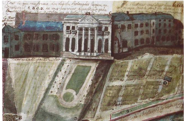
Château des Riolles construit sur les vestiges de la maison des Chanoines réguliers, extrait de l'ouvrage de Pierre Lallemand, Pont-à-Mousson, au cœur des rues, op. cit.
