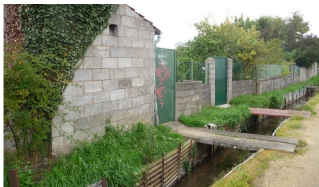
Accès aux jardins familiaux depuis le chemin de la Planchotte
