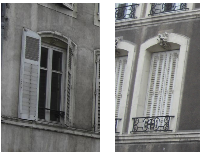
Baies d'étage courant à linteau cintré délardé
