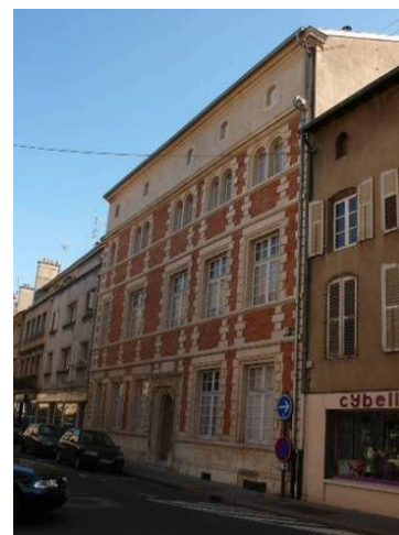
Façade du 11, rue Saint-Laurent, MH
