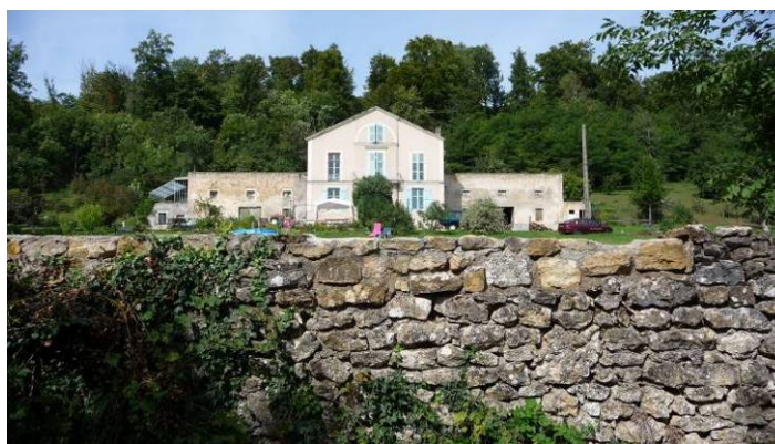
Mur de pierre en limite de propriété au niveau du 'Haut de Rieupt'
