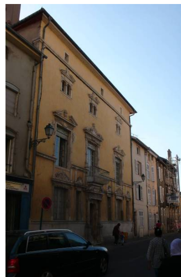
Façade du 19, rue Saint-Laurent, MH
