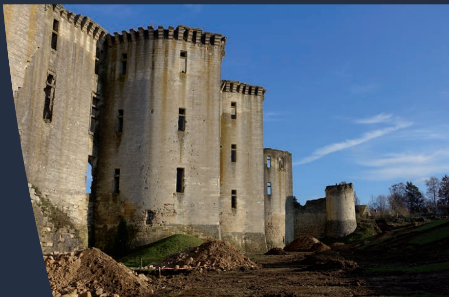
Fouilles au niveau des douves du château de La Ferté-Milon
