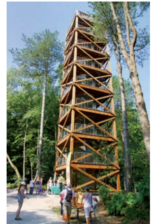
Inauguration de la tour Mangin en juillet
