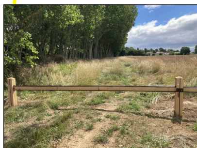
Installation d'une barrière anti-intrusion par le CMN (Centre des Monuments Nationaux)
