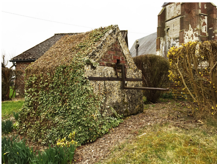
Puits dans la commune de Rocquencourt
