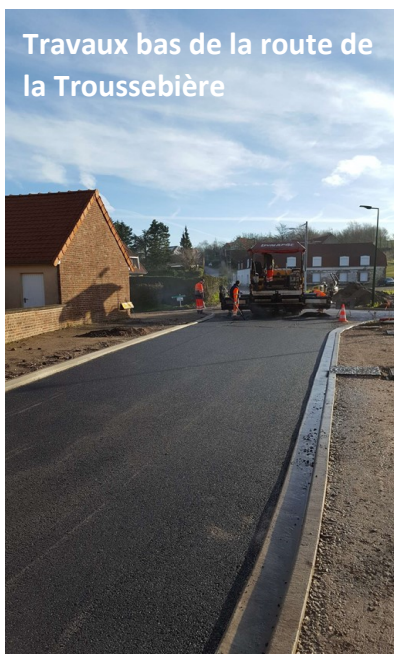
Travaux borduration et trottoir route de Cormette
