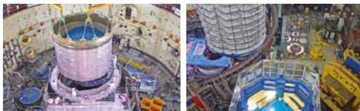
Le 4 septembre 2019, les équipes du site EDF de Creys-Malville ont retiré le petit bouchon tournant en 3h30. Cette pièce de 212 tonnes, haute de 3,3 mètres et d'un diamètre de 7,1 mètres contribuait au transfert du combustible dans la cuve lors du fonctionnement de Superphénix. Déposée sur un support spécifique, elle a été préparée en vue de son transfert dans un atelier dans le bâtiment réacteur pour être découpée.
