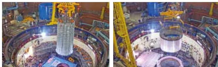
Lors de l'extraction du bouchon couvercle cœur, les techniciens habilités ont circulé sur une plateforme, installée sur la dalle de la cuve. Cette pièce de 12 tonnes (en bleu sur la photo) permet aux équipes de travailler en toute sécurité. Une virole, anneau de 11,5 tonnes, positionnée sur la plateforme, a servi de protection biologique durant toute la durée des opérations de manutention.
