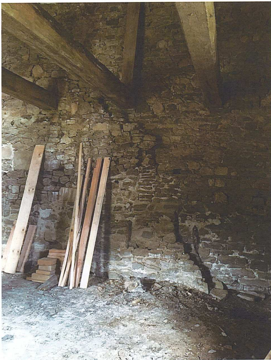
Fig.71, intérieur de l'étable (3), 1 : traces de reprise de maçonneries sur le mur nord, 2 : vestiges des attaches des vaches sur le mur sud.
