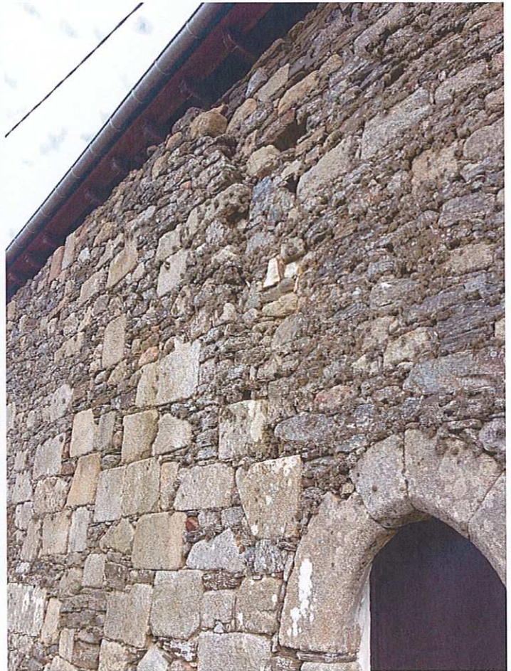
Fig.68 : façade nord, 1 : logis 1 et 2 accolés, 2 : réemploi de gros blocs de granite gris, 3 : porte en arc brisé et traces d'arrachement.
