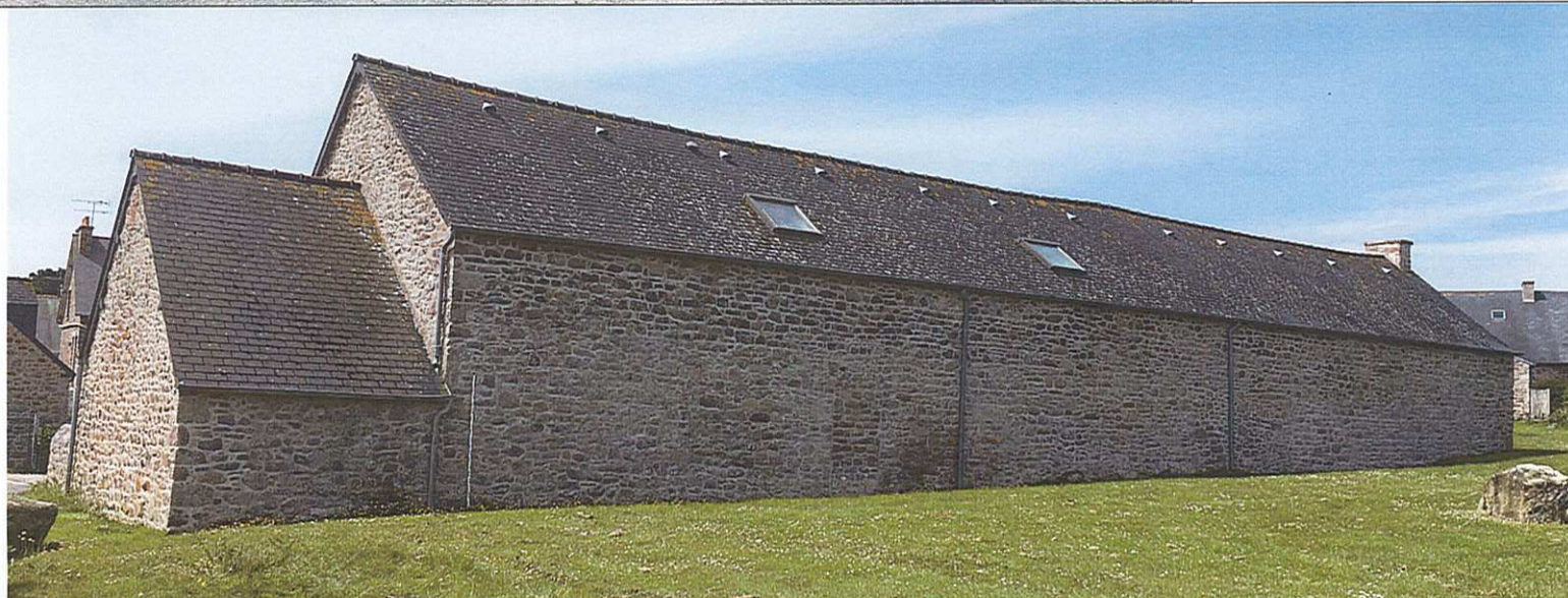
Fig.44, vues de la métairie de l'Abbaye, 1 : façade sud, 2 : détail sur le pignon ouest, 3 : façade nord.
