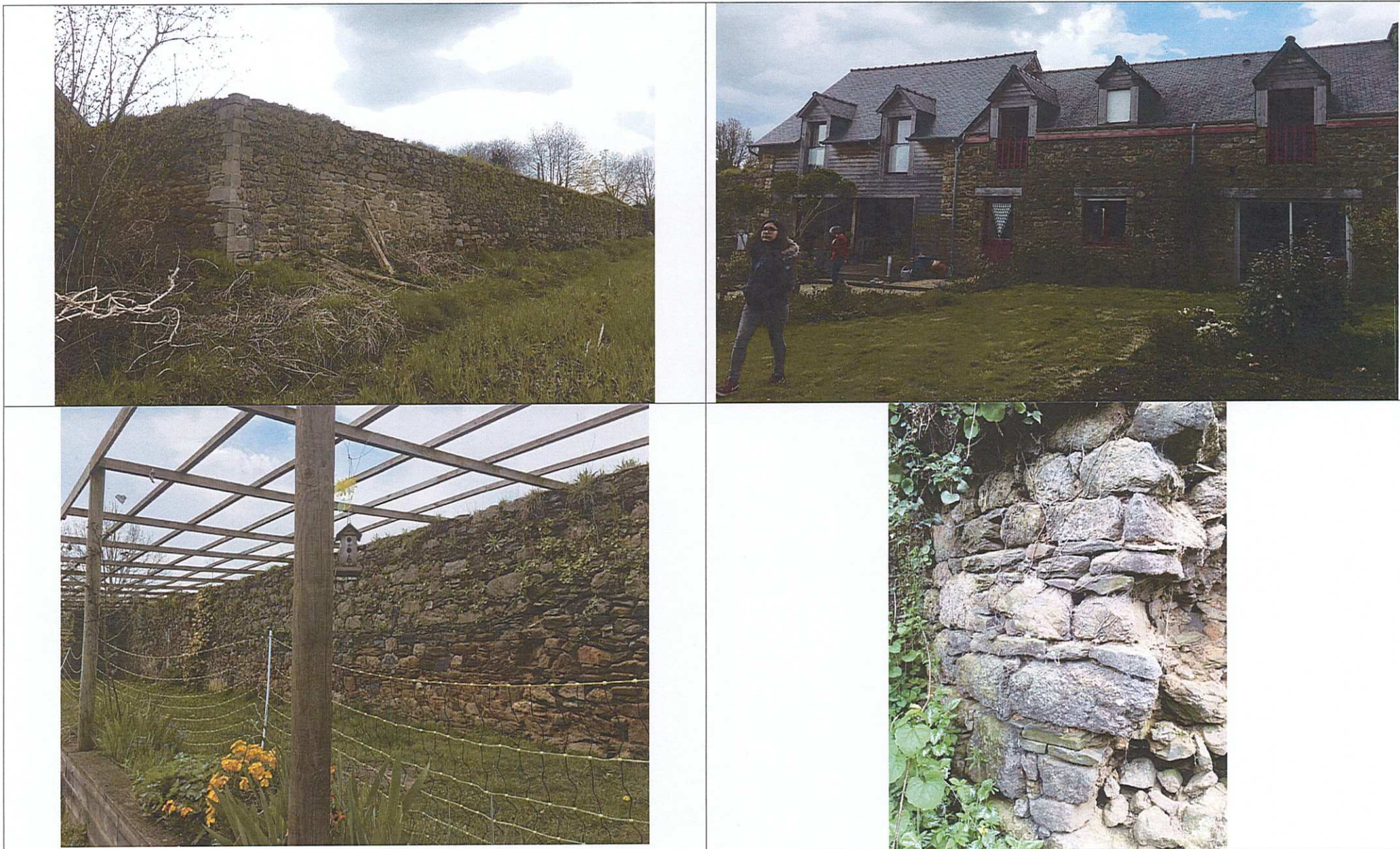
Fig.8 : état actuel de la Porte, 1 et 3 : le manoir et la bergerie, 2 : le logis, 4 : détail du four.
