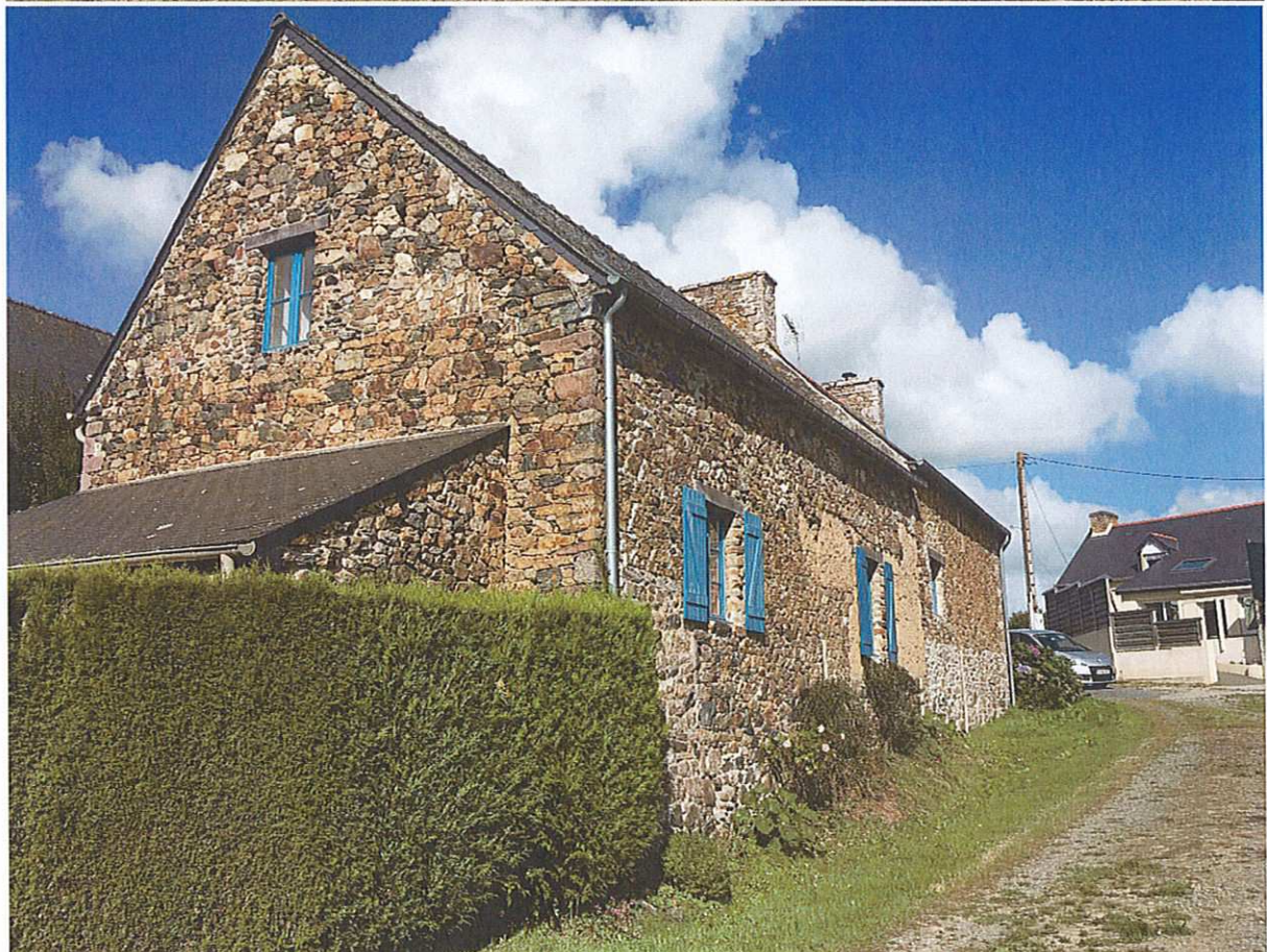
Fig.58 : vues du village de Saint-Maleu, 1 : la forge, 2 : la grange.
