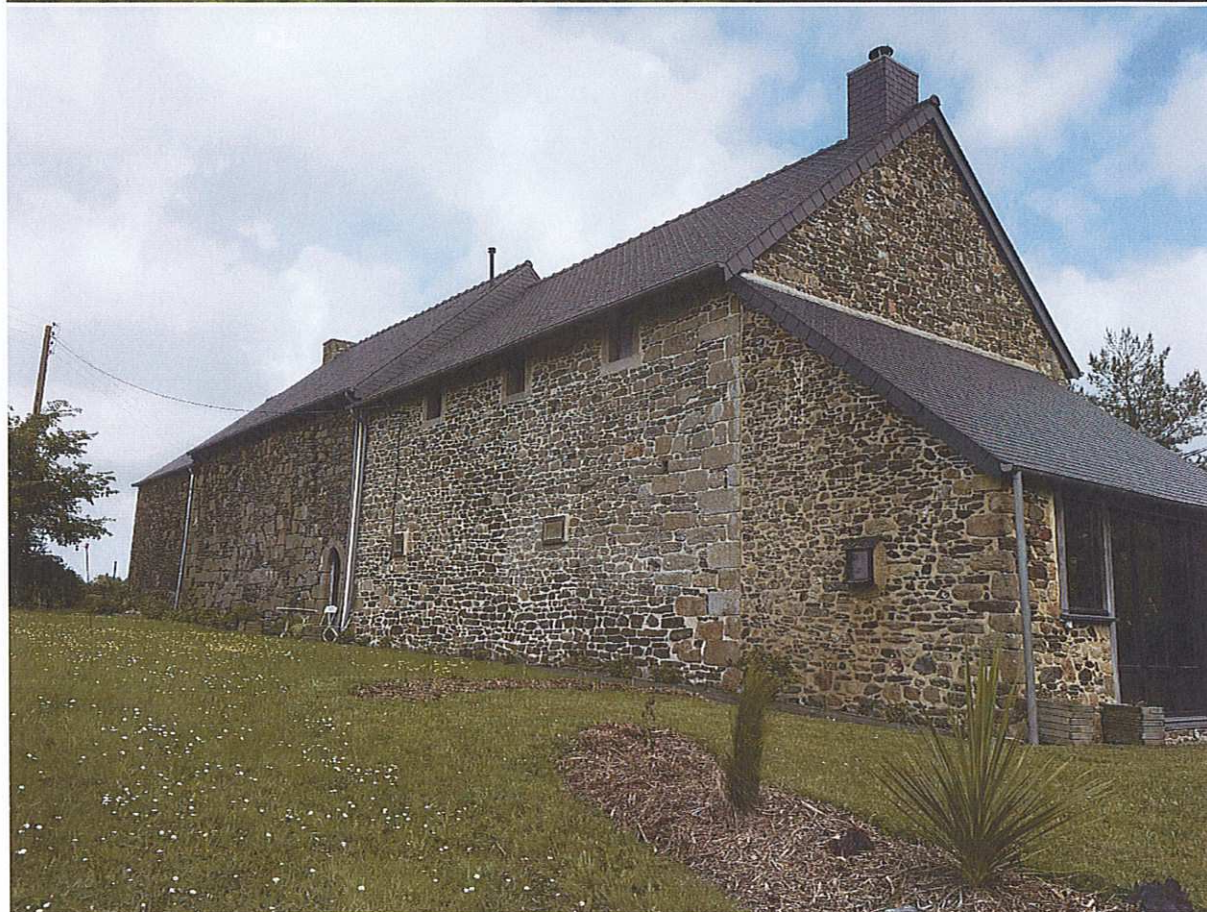
Fig.69 : l'appentis vue du sud (1, fonds privé), et du nord (2).
