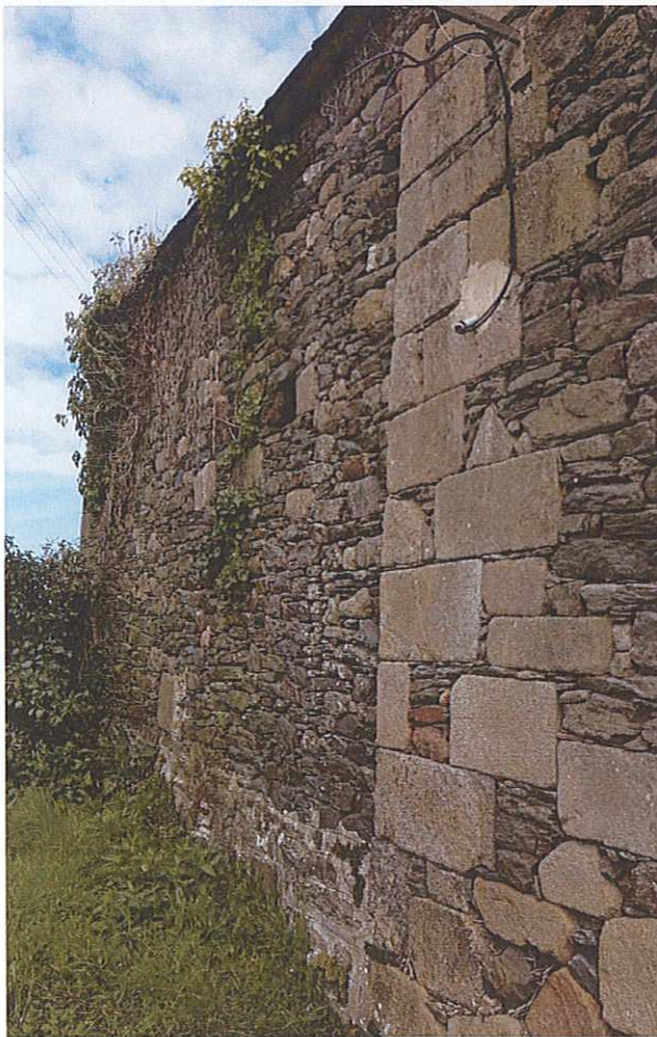
Fig.68 : façade nord, 1 : logis 1 et 2 accolés, 2 : réemploi de gros blocs de granite gris, 3 : porte en arc brisé et traces d'arrachement.
