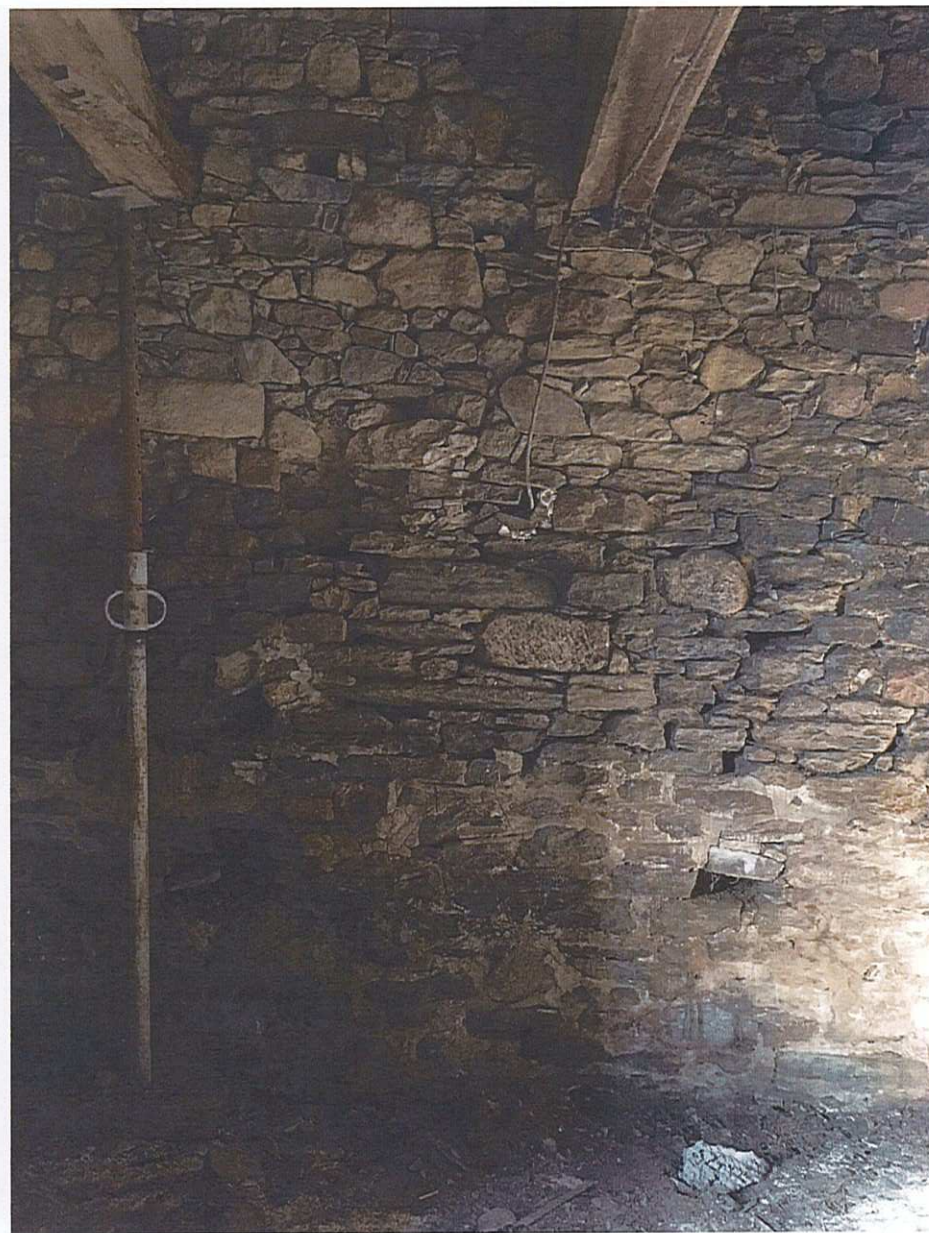
Fig.71, intérieur de l'étable (3), 1 : traces de reprise de maçonneries sur le mur nord, 2 : vestiges des attaches des vaches sur le mur sud.
