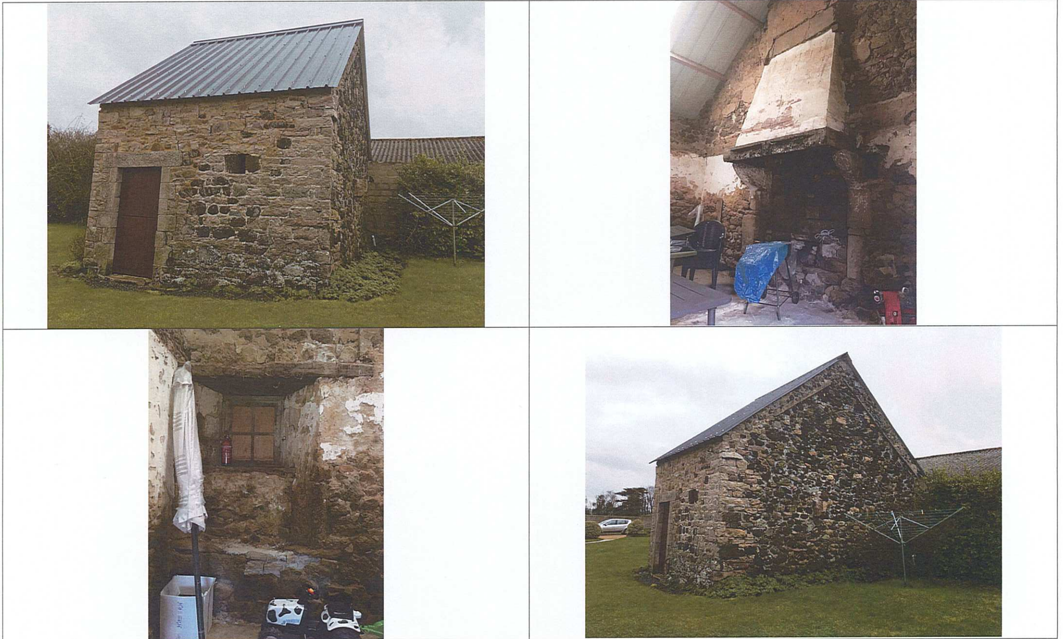
Fig.36, vues de la vieille Moinerie, 1 : façade nord, 2 : cheminée à hotte comportant un écusson effacé sur le linteau, 3 : fenêtre à fort ébrasement, 4 : traces de faîtage sur le pignon ouest.
