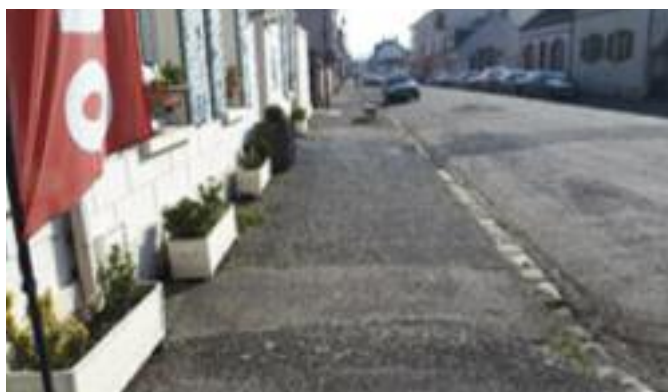
Le boulevard U. Lavertu, avant les travaux
