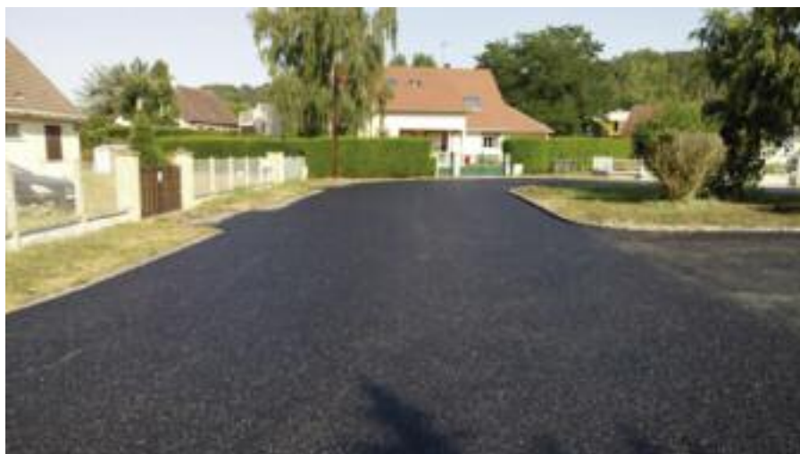
Lotissement des Acacias, après les travaux, dans l'une des raquettes
