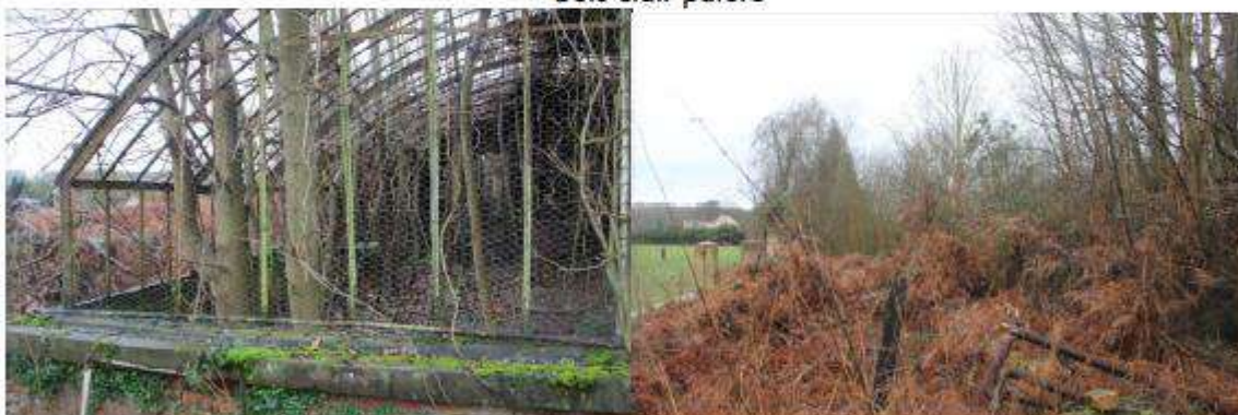
Anciennes serres envahis par les arbres et arbustes
