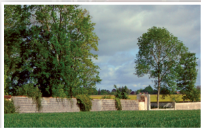
Mur en l'état avant sa rénovation
