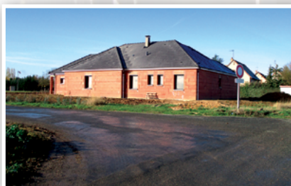
Aménagement du lotissement de la rue de la Grande Ruelle à Bailleau
