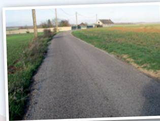
Réfection du chemin des 3 saules à Levesville
