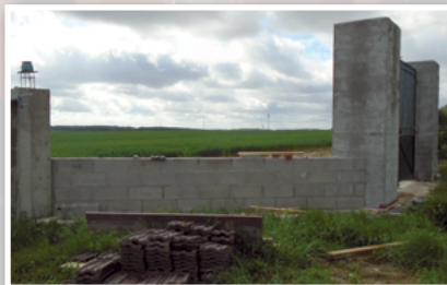
Avancement des travaux
