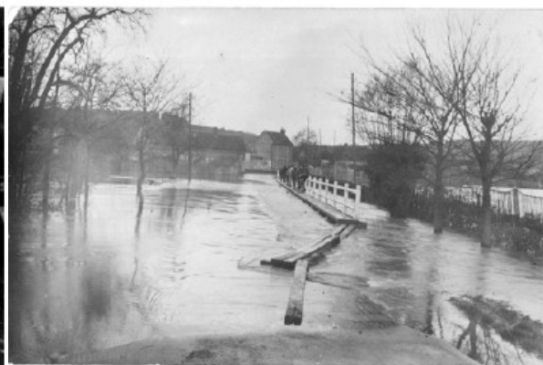
Figure 7: Photo prise au Nord de la RD 836 d'un aménagement permettant d'assurer la continuité d'un axe préférentiel d'écoulement en lit majeur (crue de 1930)
