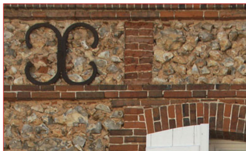
Maçonnerie de brique et silex.
