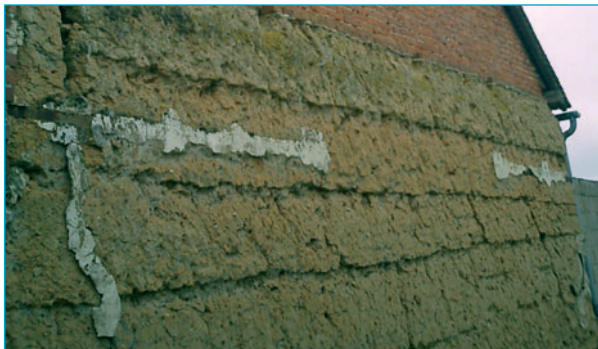
Mur en bauge. Broué.
