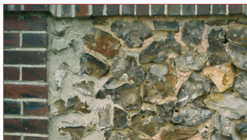
Maçonnerie de brique et silex.
