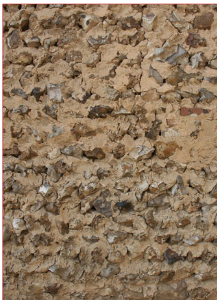
Maçonnerie de silex
