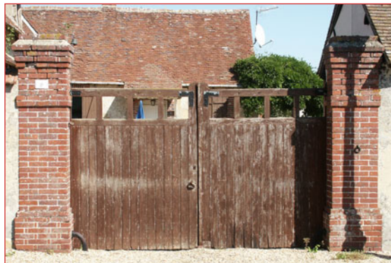
Portail avec piliers en brique. Tremblay-les-Villages
