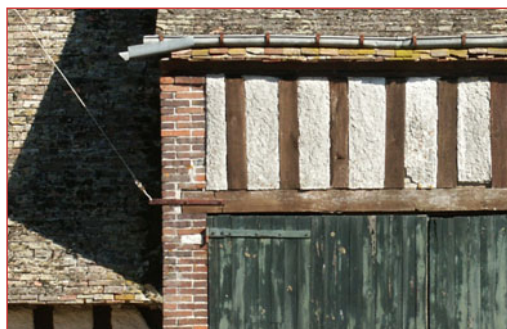
Colombages protégés par un lait de chaux.
