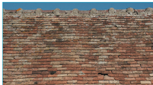
Le faitage des toitures en tuile
