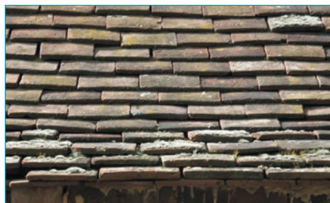
Toit débordant en tuile
