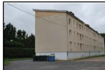
L'immeuble de la rue de la Petite Cité
