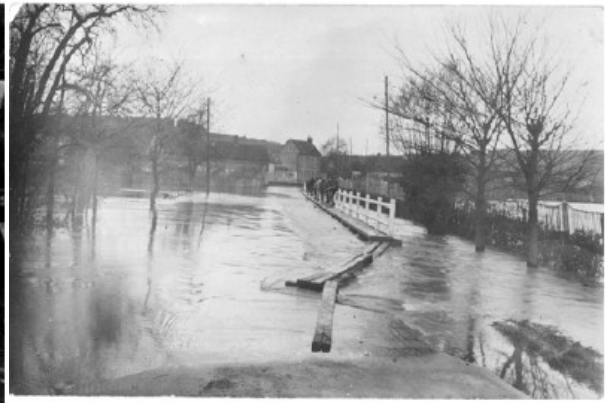
Figure 7: Photo prise au Nord de la RD 836 d'un aménagement permettant d'assurer la continuité d'un axe préférentiel d'écoulement en lit majeur (crue de 1930)
