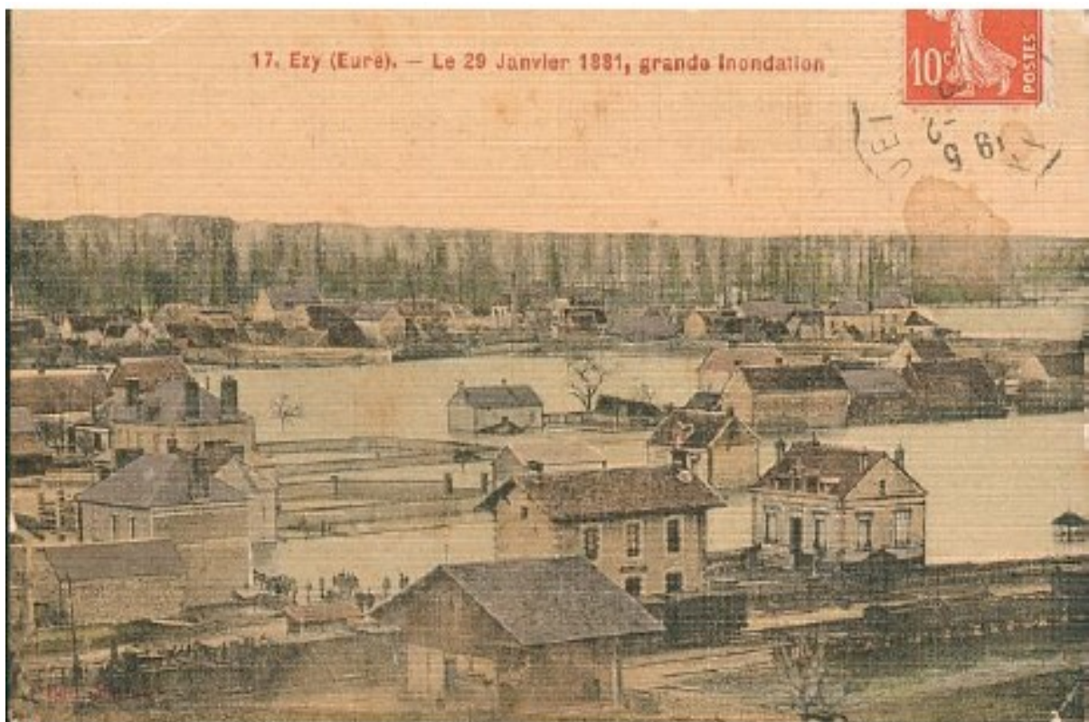
Figure 4: Carte postale de la grande inondation du 29 janvier 1881 à Ezy-sur-Eure
