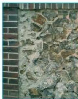
Mur en silex et chaîne en brique.
