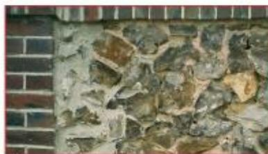
Maçonnerie de brique et silex.
