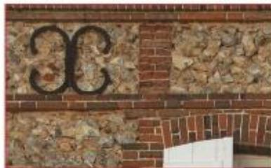
Maçonnerie de brique et silex.
