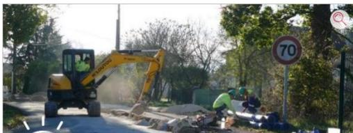
des réseaux électriques et téléphoniques de la route du Causse jusqu'au bas de la côte du chemin des rouges. Ces travaux devraient démarrer mi-mars et durer environ 4 à 6 semaines. Une fois les enfouissements terminés, les travaux de voirie pourront démarrer.
