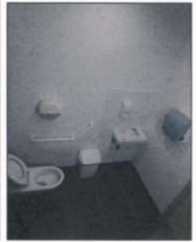
Création de WC PMR
