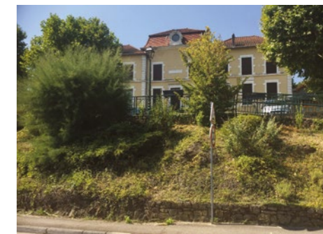
Des espaces verts dégradés et vétustes
