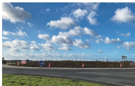
Novembre, aménagement du Rond-Point du stade
