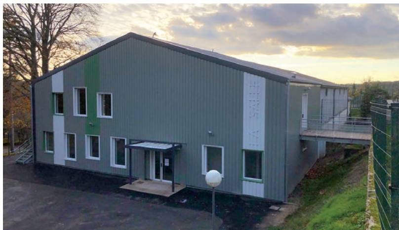
Salle polyvalente / façade avant
