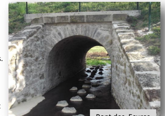
Pont des Eures
