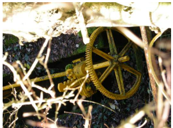
La vanne de régulation du débit d'eau du moulin banal est encore existante. Cliché Henri DONZAUD, 13 janvier 2017
