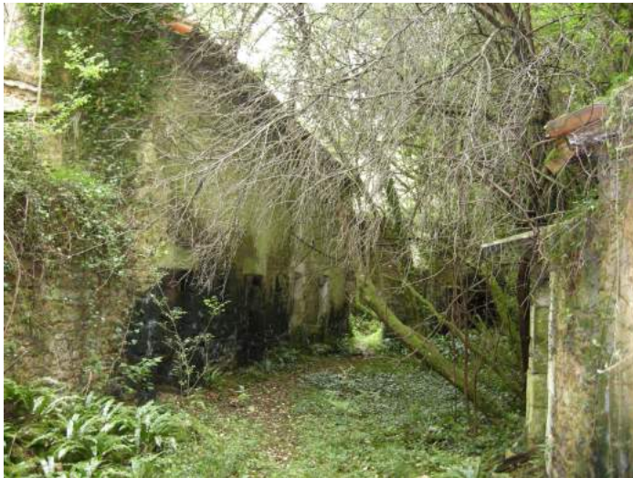
Les ruines du moulin de Chambon. À gauche, le bâtiment principal ; à droite, des dépendances. Cliché Henri DONZAUD, septembre 2015.
