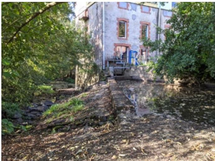
L'ancienne minoterie (Moulin Charron ou Pé Garnier) en aval du bourg est installée sur la base d'un moulin à eau qui utilisait la force hydraulique de la Logne. Ce fonctionnement nécessitait un ouvrage barrant le cours d'eau, une chaussée, pour obtenir une hauteur de chute suffisante.
