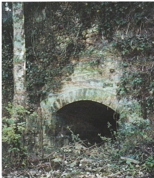
Le mur de parement du four de Haute Belle. Photo Christiane Donzaud, avril 1984.
