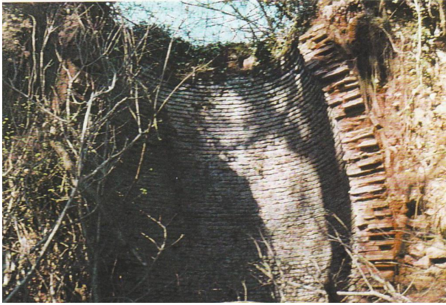
Le four de la Motte-Contais à Brion en 1982. Éventré, il laisse paraître sa forme et la maçonnerie en petites briques réfractaires. Photo Liliane Chatelier.
