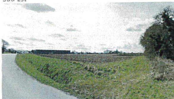
3 – Vue sur le secteur depuis la RD 230 qui borde la future zone d'activités à l'Est
