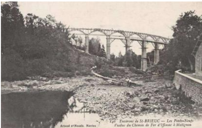
Le viaduc des Ponts-Neufs
