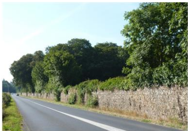
Parc des Aubiers
