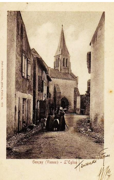
Le clocher, rapporté plus tard, crée des dommages aux murs. Carte postale.
