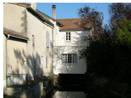
Le moulin du Pinier, la sortie du bief.
