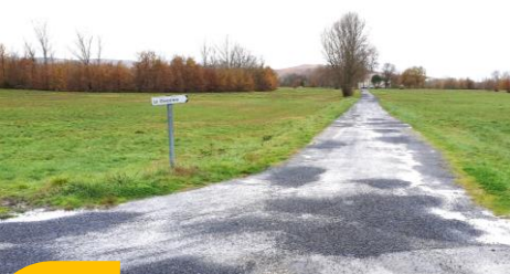
Point à temps sur la CR 2 : chemin de «La Ginestière»
