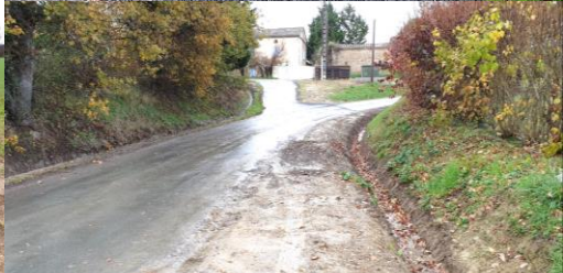
Curage de fossés sur la VC 10 à Fréjeville «Route des Étangs»
