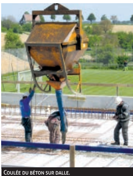
COULÉE DU BÉTON SUR DALLE.
