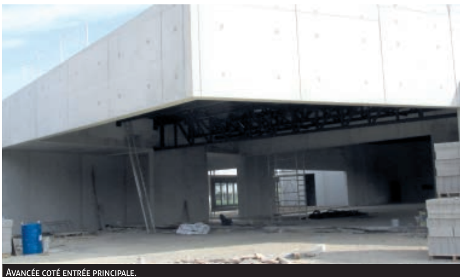
AVANCÉE COTÉ ENTRÉE PRINCIPALE.
