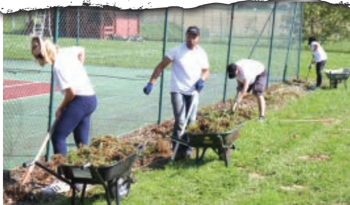
REMISE EN ÉTAT DU COURS DE TENNIS.
