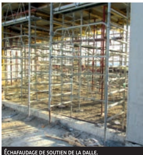
ÉCHAFAUDAGE DE SOUTIEN DE LA DALLE.
