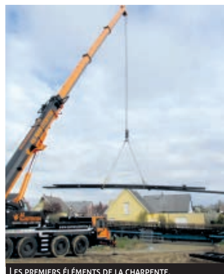
LES PREMIERS ÉLÉMENTS DE LA CHARPENTE.
