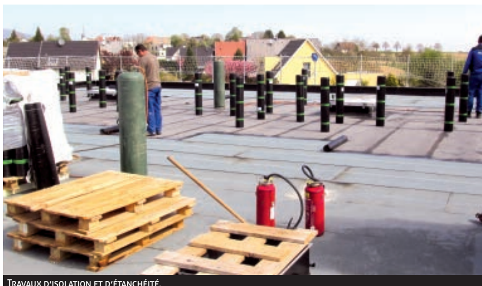
TRAVAUX D'ISOLATION ET D'ÉTANCHÉITÉ.
