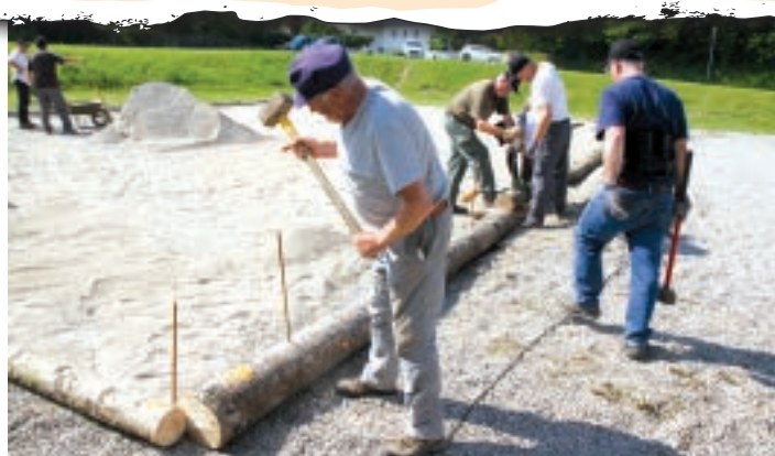
REMISE EN ÉTAT DU BOULODROME.
