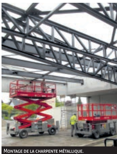
MONTAGE DE LA CHARPENTE MÉTALLIQUE.
