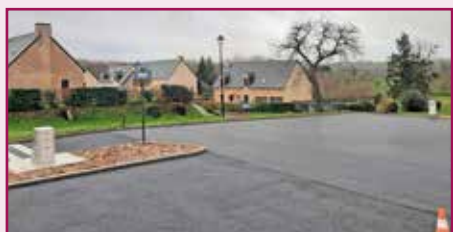
AIRE DE STATIONNEMENT DES CAMPING-CARS
