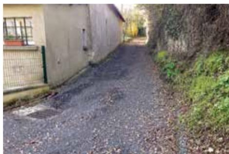
**Chemin allant de la RD47 à La Loge** : reprofilage et enduit bicouche + système de récupération et d'évacuation des eaux pluviales.
