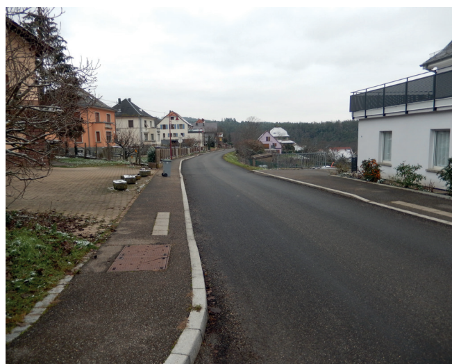
Pose d'un enrobé coulé à froid rue Ste Anne et rue du Haut-Koenigsbourg
