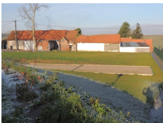
Création d'une aire de pétanque au Haut de la taillette
