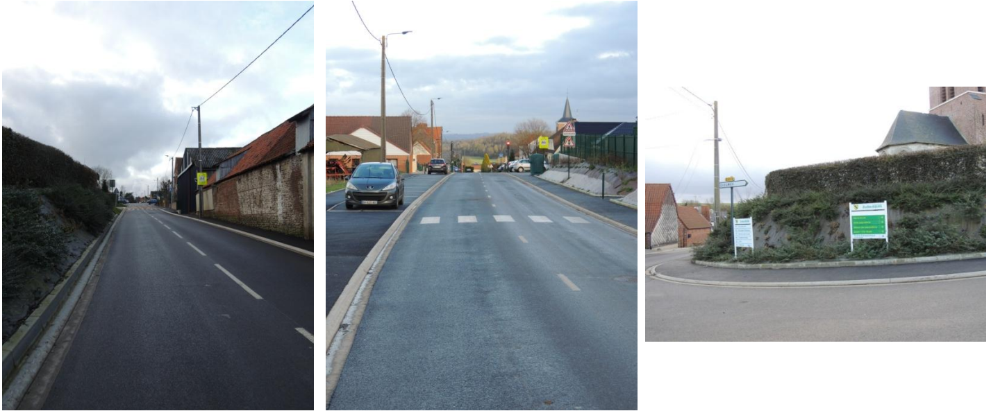
Rue de la mairie (de l'intersection de la Route de Licques jusqu'au château d'eau)
