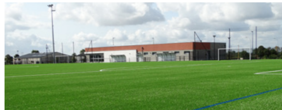
Le terrain synthétique dont l'enceinte reste fermée.
