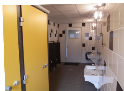
Réalisation des deux nouveaux blocs sanitaire :
