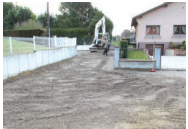
RUE DU SAULE : CRÉATION D'UN TROTTOIR.
