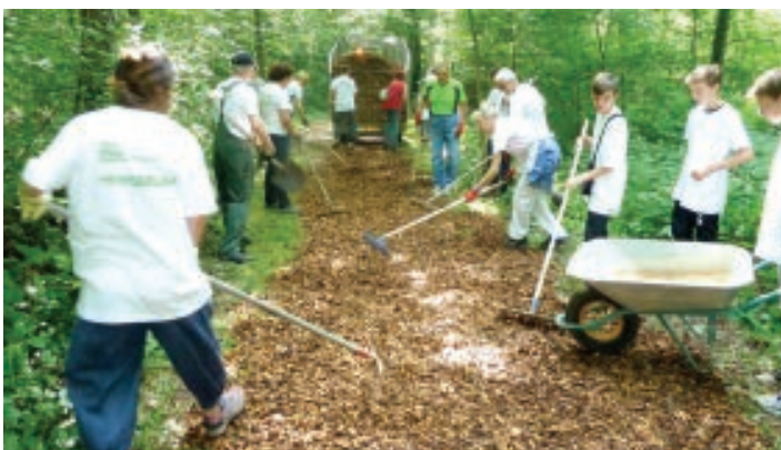
MISE EN PLACE DE COPEAUX AU PARCOURS SPORTIF.
