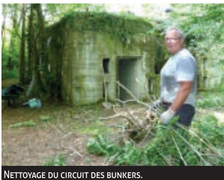
NETTOYAGE DU CIRCUIT DES BUNKERS.
