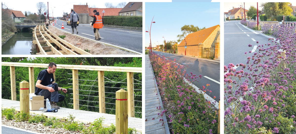
Travaux d'aménagement de l'entrée de la commune Rue Léon Coustre Passerelle - trottoir - feu tricolore - voie partagée - éclairages LED - fleurissement...
