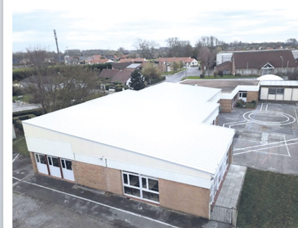
Travaux à l'école Réfection de la toiture
