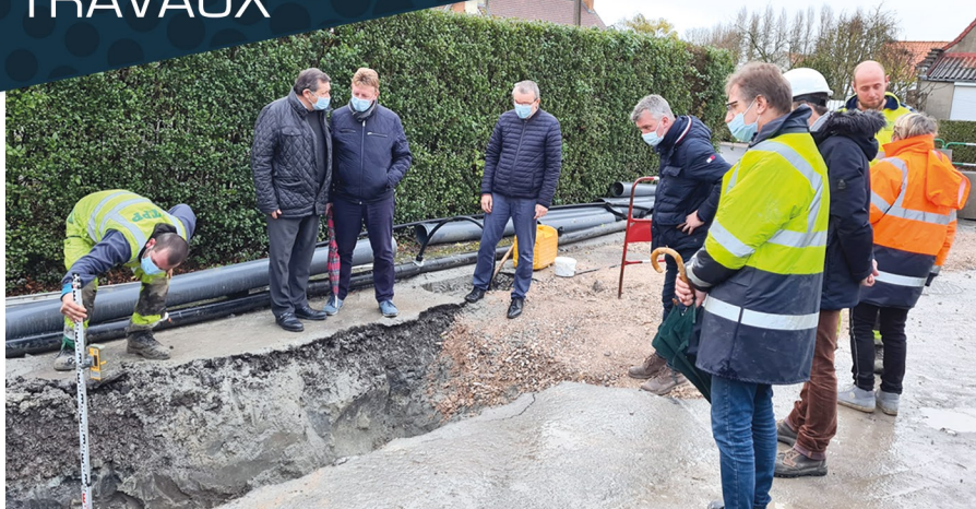
Travaux Rue Becquet et lotissement la Loquinette Assainissement
