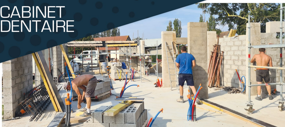
Construction et installation d'un cabinet dentaire M. Sébastien GEERAERT
