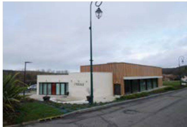
UNE NOUVELLE SALLE DES FÊTES FACE À L'ÉGLISE : DES BATIMENTS (MODERNE ET ANCIEN) ASSEYANT LE STATUT DE CENTRE-VILLE
