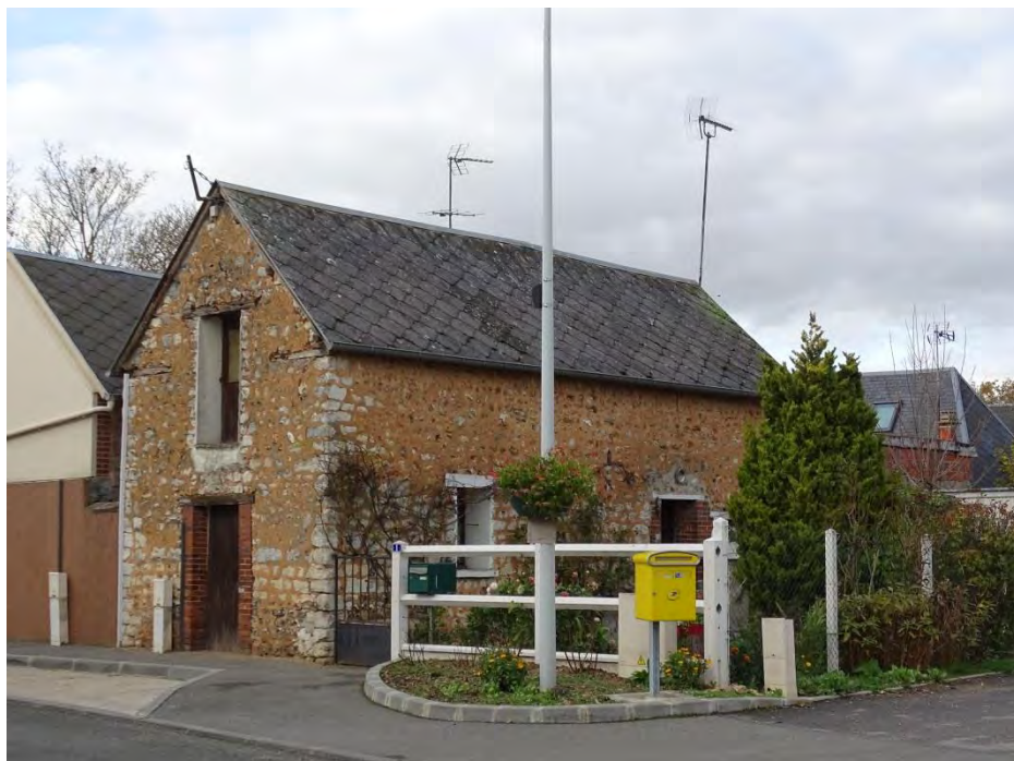
Bâtiment 1 bis rue Aviron
