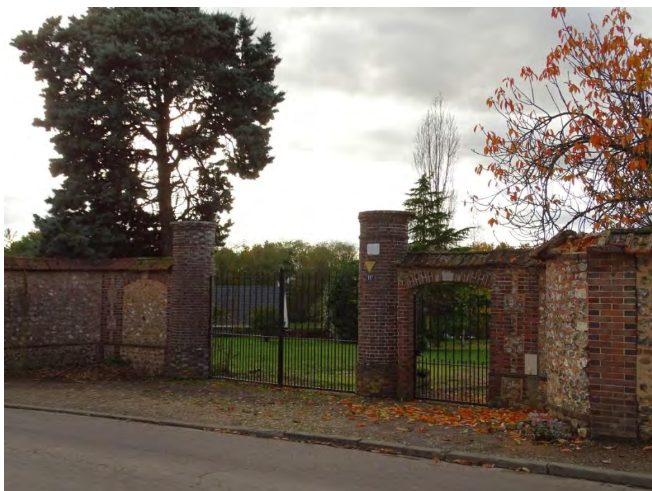
15 rue du Neubourg : Mur et piliers
