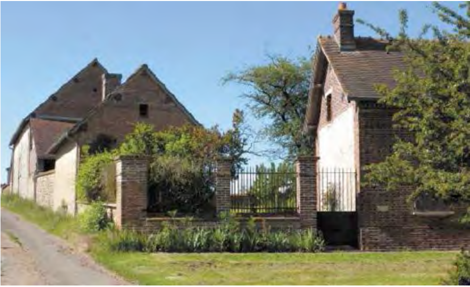
Immeuble, piliers et murs bahuts, chemin de la Croix Blanche
