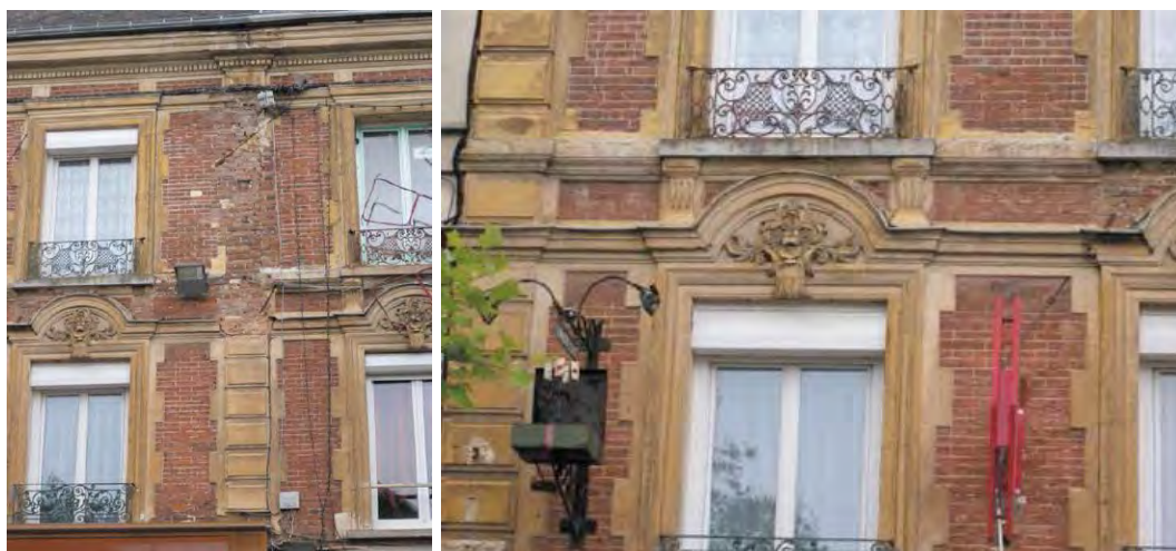
Immeuble du 33 rue du Chanoine Boulogne
