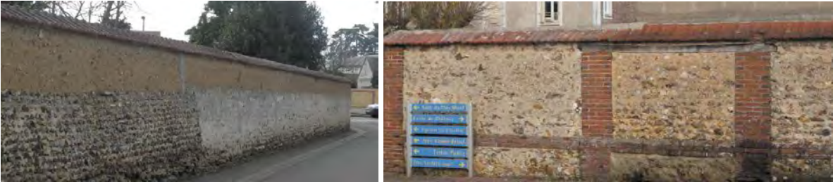
Mur en terre crue 37 route de Dreux
