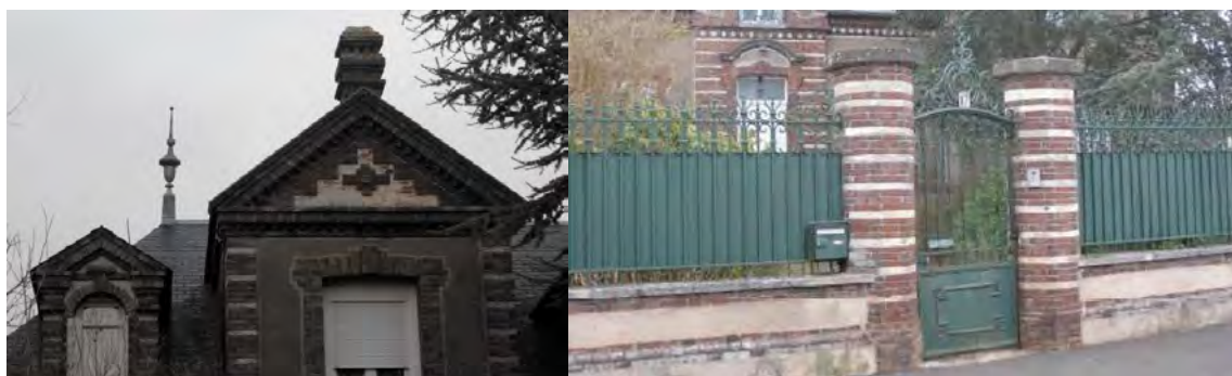
Immeuble, piliers et murs bahuts 17 rue du Maréchal Joffre
