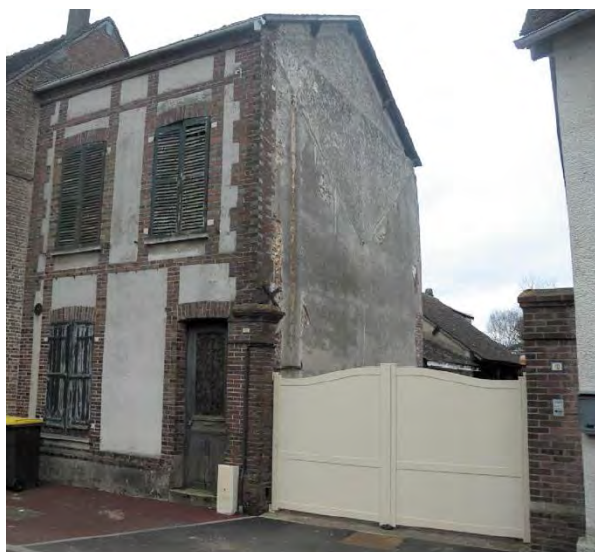
Immeuble, piliers 12 rue du Maréchal Joffre
