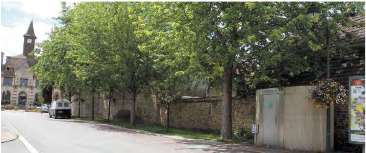
Murs en terre crue place Gambetta
