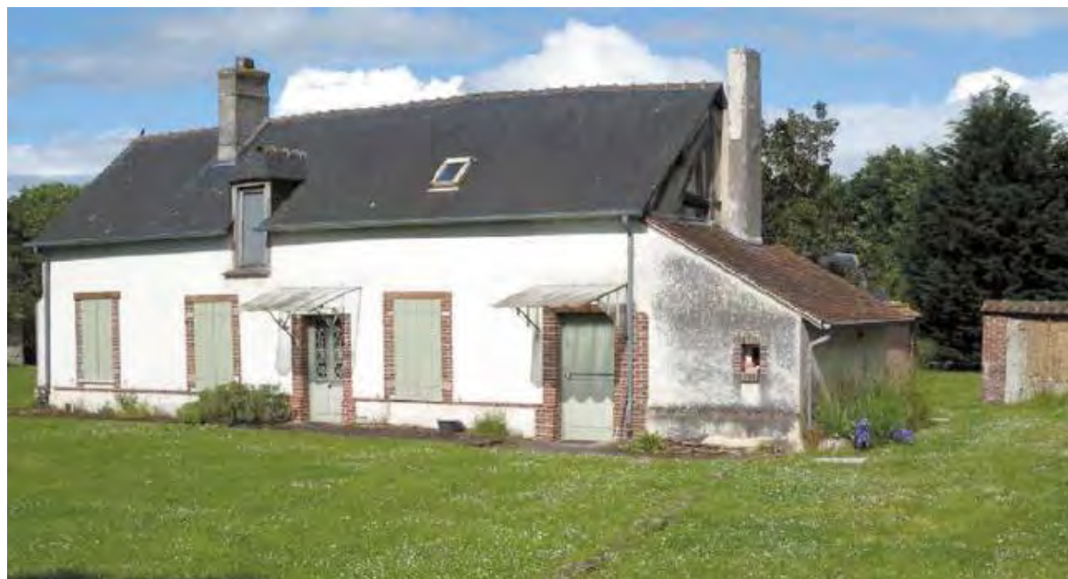
Immeuble 11 rue des Moulinards
