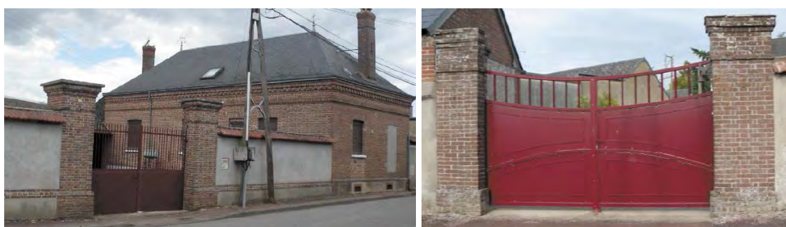
Immeuble, piliers et murs 27 rue de Pacy
