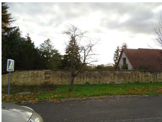
Mur, angle de la rue du Neubourg
