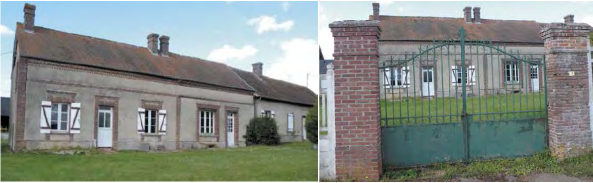
Immeuble, pilier 17 rue de la Vigne
