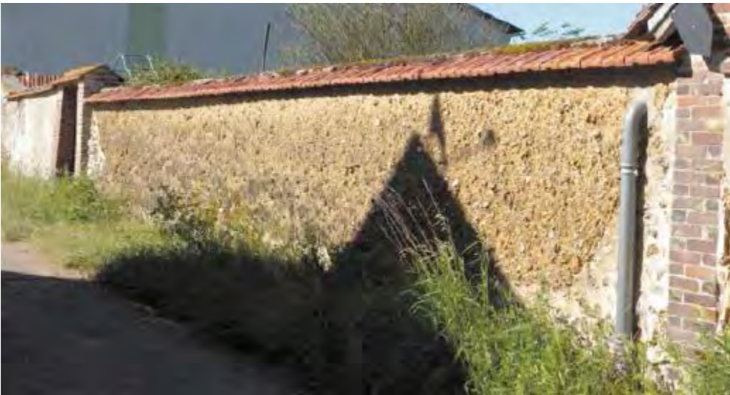
Mur en terre crue Chemin de la Croix Blanche
