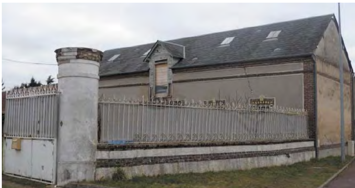
Immeuble 16 rue de la Libération : bâti, piliers et mur bahut
