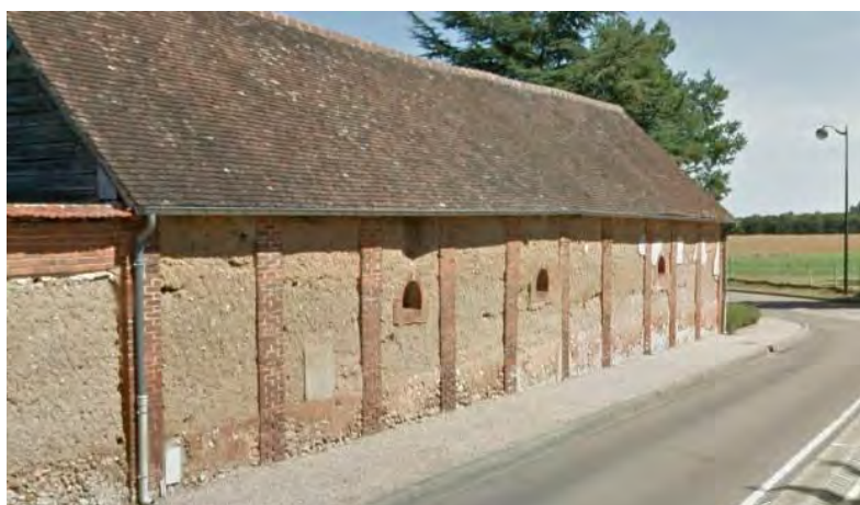
Ancien bâtiments de corps de ferme, rue de la ferme
