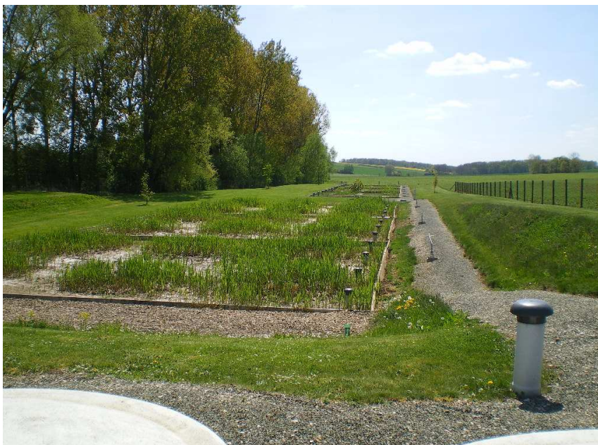
La station d'épuration de Sancy-lès-Meaux
