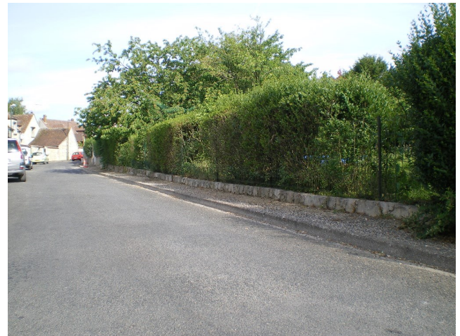
Réhabilitation de trottoirs, rue de Cramayel
