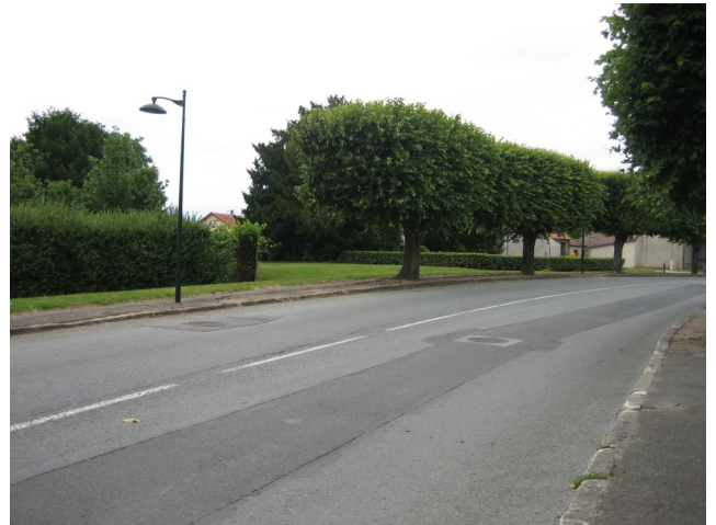
Retrait d'une partie des barrières, au droit de l'ancienne école
