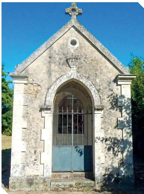
Figure 3 Chapelle de la Giraudière, commune de Bazoges-en-Pareds, façade, côté Ouest. Cliché Alain Rouhaud, 2013
