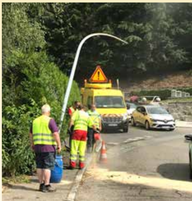
Enlèvement du poteau abîmé suite à un accident de voiture sur la RD417.
