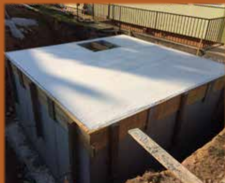
Construction du silo
