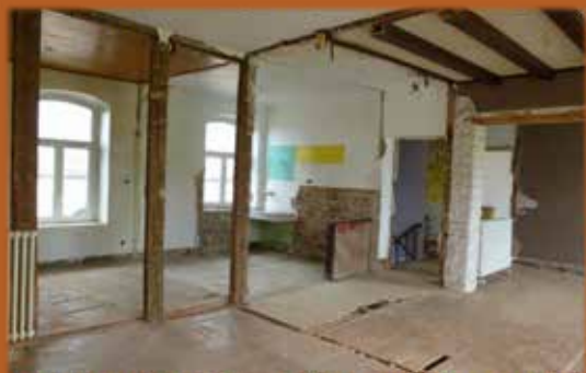
Travaux en cours de réalisation
