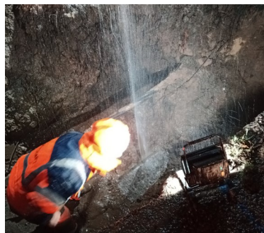
Réparation d'une fuite
