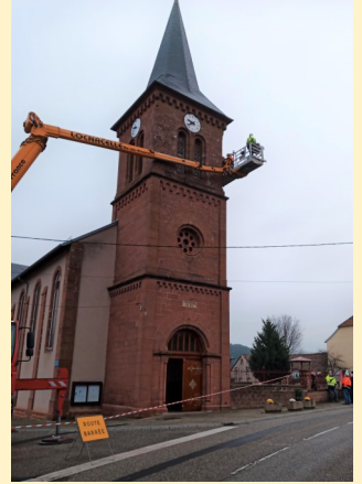
Prise de mesures pour le remplacement des abat-sons
