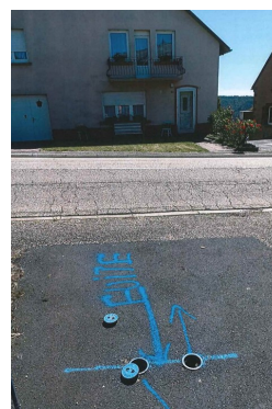
Matérialisation des casses entre 2 vannes individuelles, rue Charles de Gaulle, et sur la conduite principale, route du Zollstock.
