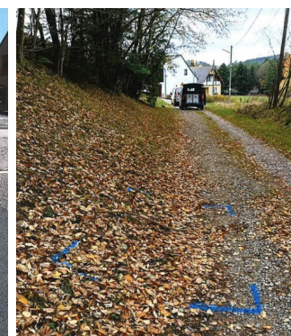
Matérialisation des casses entre 2 vannes individuelles, rue Charles de Gaulle, et sur la conduite principale, route du Zollstock.
