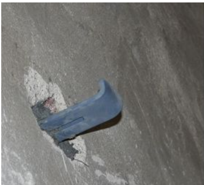
Détail de la serrurerie: installation de pattes antivol dont une partie est fixée au mur (à gauche) et l'autre dans la boiserie (à droite). L'ensemble est solidarisé par une visserie en inox au moment de la pose.
