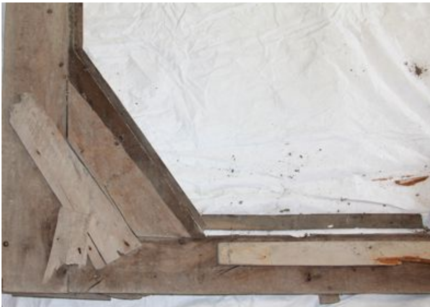
Détail de la feuillure de la boiserie après démontage de l'ensemble dos protecteur et toile
