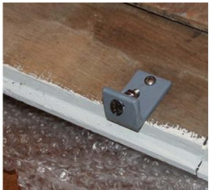
Détail de la serrurerie: installation de pattes antivol dont une partie est fixée au mur (à gauche) et l'autre dans la boiserie (à droite). L'ensemble est solidarisé par une visserie en inox au moment de la pose.
