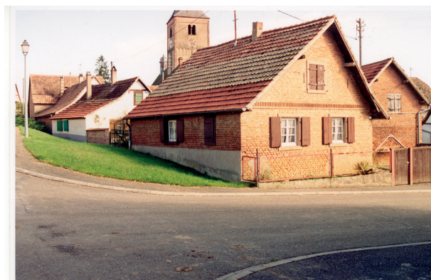
s'Schnieder-Dònie avant sa démolition
